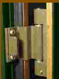
Bisagra antipalanca. Charnière antipalanque. Hinge antilever.
